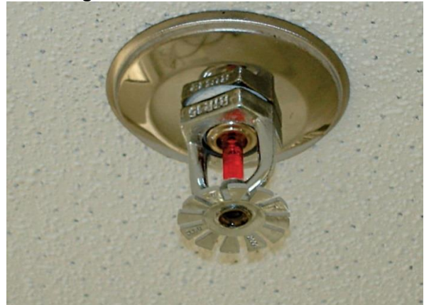
Figura 23 – Chuveiro automático.
