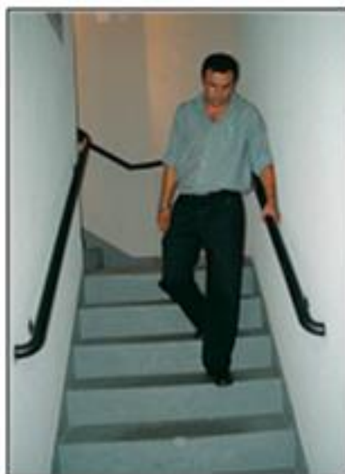
Figura 9: Escada com largura apropriada para saída das pessoas.
