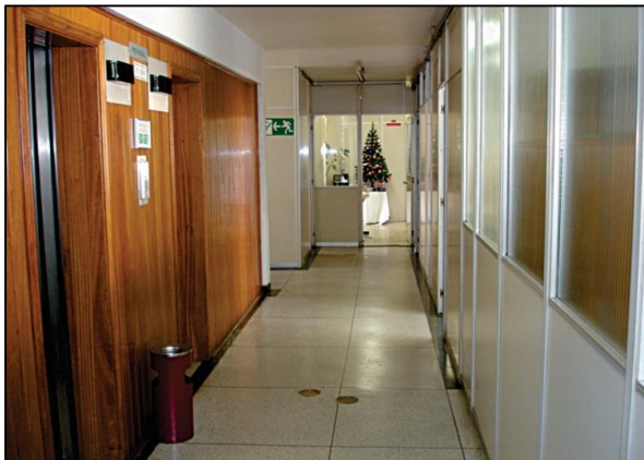
Figura 14: Corredor desobstruído e sinalizado.
